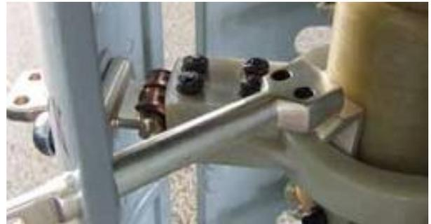
**Fig. 7 Contatos do Seletor de Tap**
